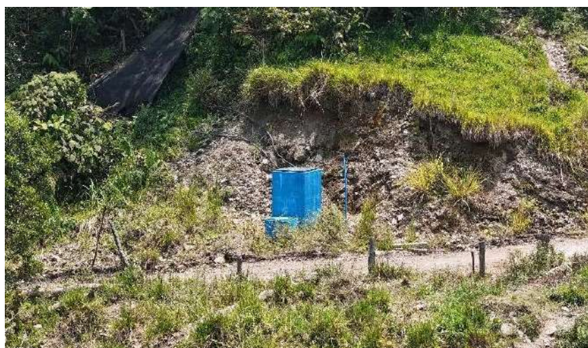
Imagen 54. Foto del Tanque de captación 2.
