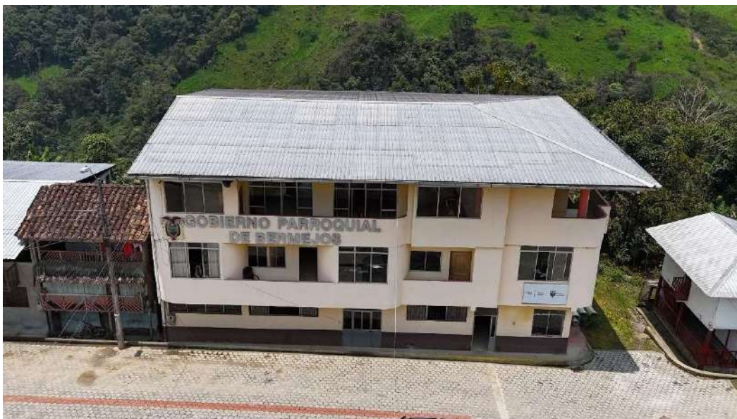
Imagen 50. Foto del edificio del Gobierno Parroquial de Bermejós.
