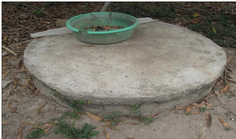
Se encuentra un pozo séptico para la evacuación de las aguas servidas. Este tipo de estructuras se localizan mayormente en la parte posterior de los hogares. Estas estructuras pueden ser afectadas al momento de la inundación; comúnmente después de la misma, se las puede restaurar.
